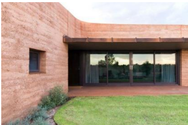
Figur 3. Husvägg av stamp-tekniken "rammed earth". (Bildkälla: Terra versa 2024)
