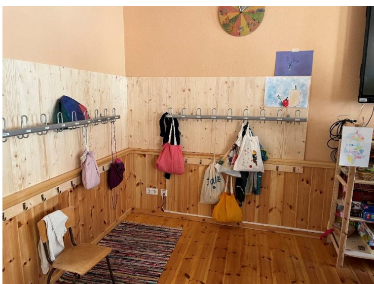
Figur 24. Träpanel vid krokarna för att skydda lerputsen.
