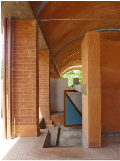
Figur 4. Husvägg av komprimerade lerblock. (Bildkälla: Terra versa 2024)
