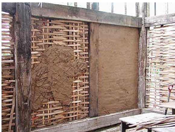
Figur 8. Vägg i korsvirkeshus under byggnation. (Bildkälla: Lowimpact 2016)
