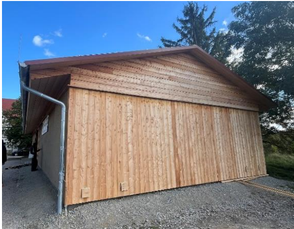
Figur 30. Värderutsatt sida skyddas med träpanel.
