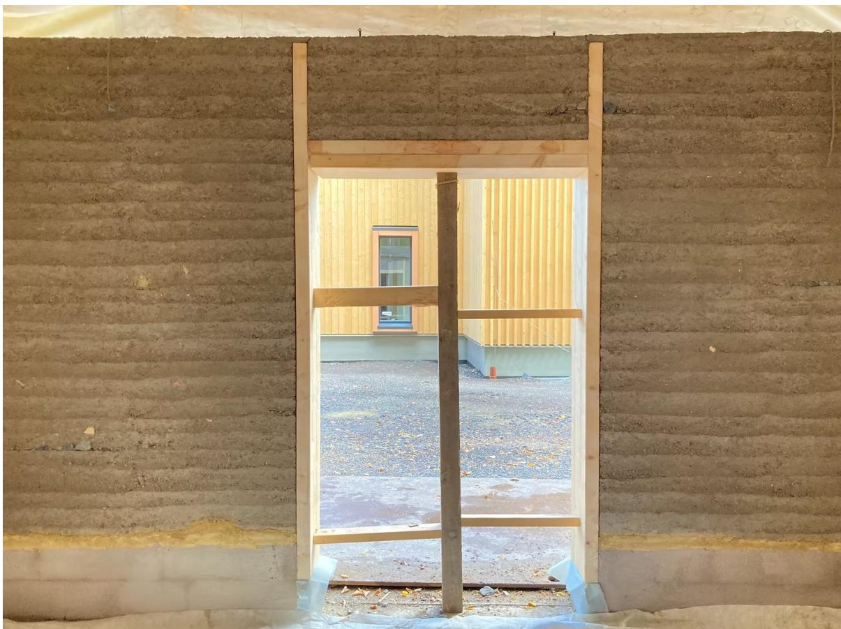
Figur 42. Stampad jordvägg i sidobyggnad i sidobyggnad till Hoppets Förskola. (Bildkälla: Step 1 2023)
